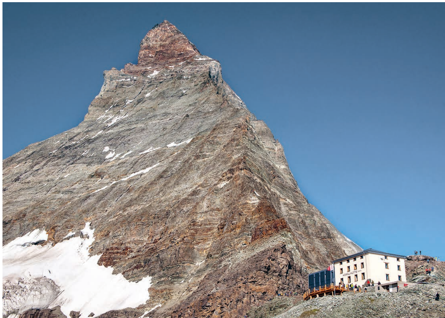
In die Referenzliste der Brawand Zimmerei AG aus Grindelwald reiht sich neu die Hörnlihütte ein. Das Basislager am Matterhorn öffnete 2015 mit dem neuen Holzanbau (links).
